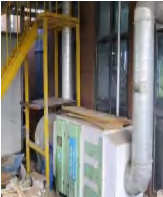
图4-2 UV光氧化催化装置
